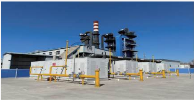
190万平米小区供暖采用装配式能源站，从设计、生产、交付、调试使用仅用30天。传统锅炉房施工周期至少90天。
