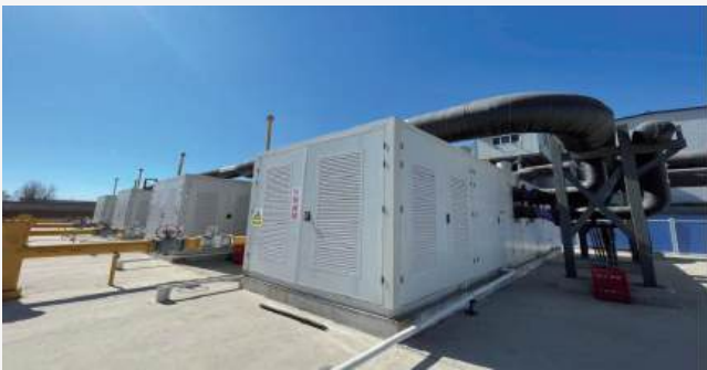
190万平米小区供暖采用装配式能源站，从设计、生产、交付、调试使用仅用30天。传统锅炉房施工周期至少90天。
